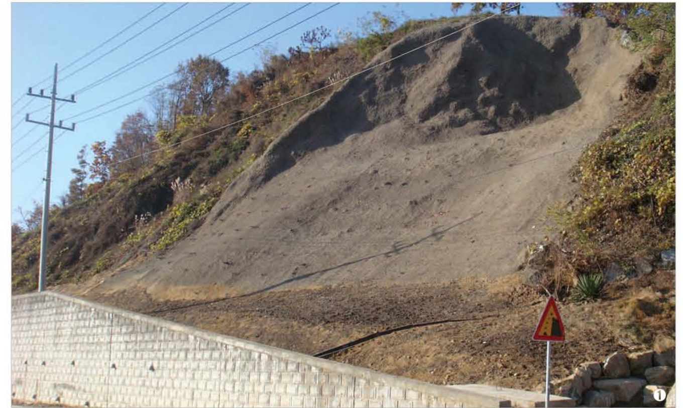
매립 및 성토지역 수해복구 비탈면 보강 및 보호
