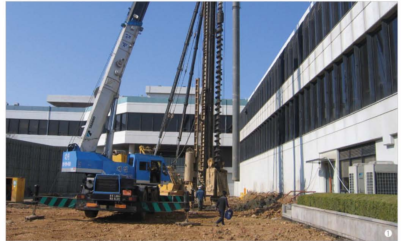
공항 국제선 청사 빌딩 말뚝기초 공사
