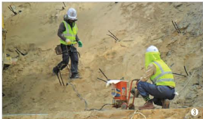
① 시공중 전경 ② 압력식S/N 천공 ③ 발포우레탄패커 주입
