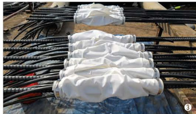
① 시공중 전경(좌측비탈면) ② 압력식S/N 천공 ③ 발포우레탄패커
