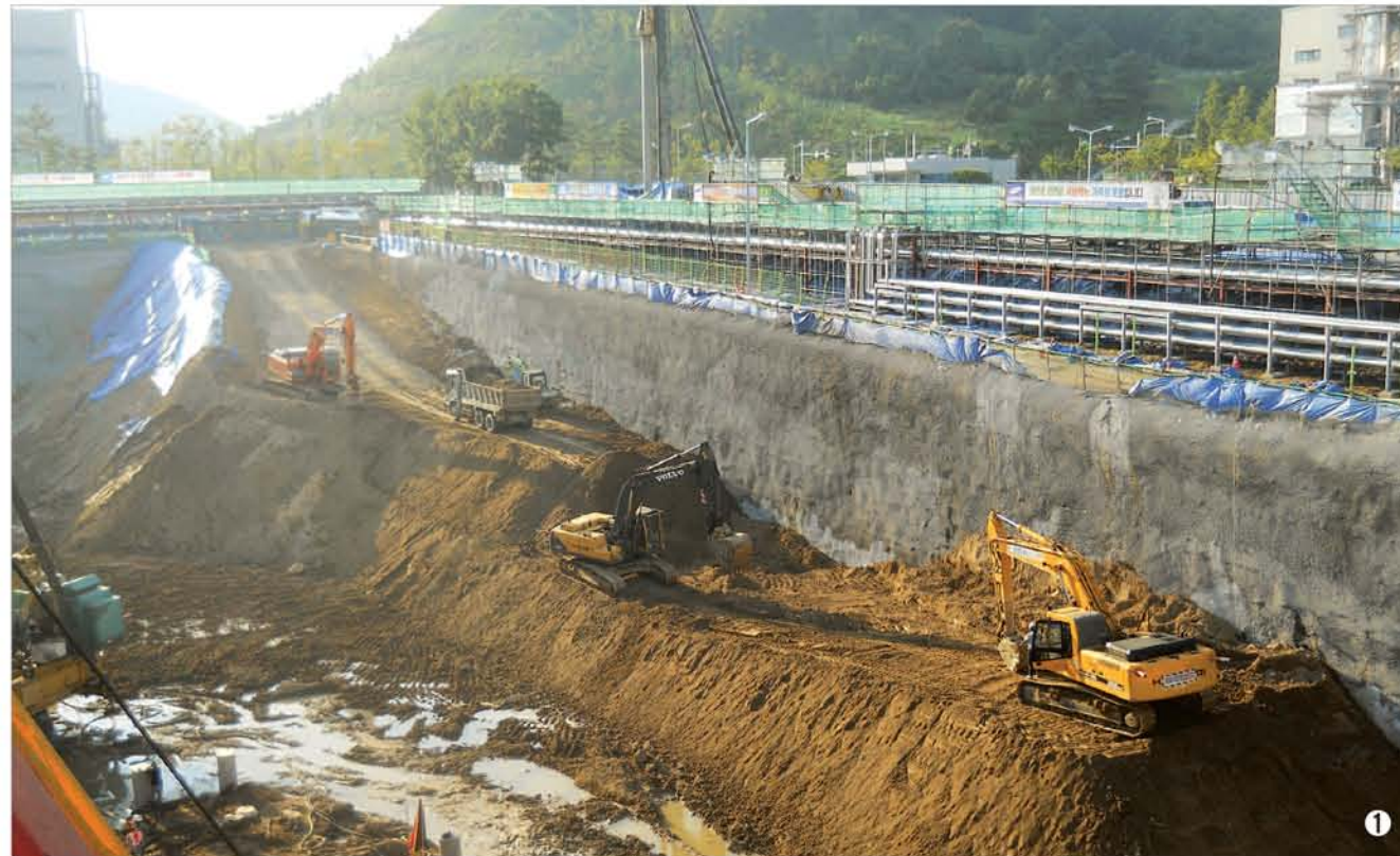
N치 50이하의 불량한 지반 및 전석층에서의 압력식 쏘일네일링 흙막이 벽체 시공
