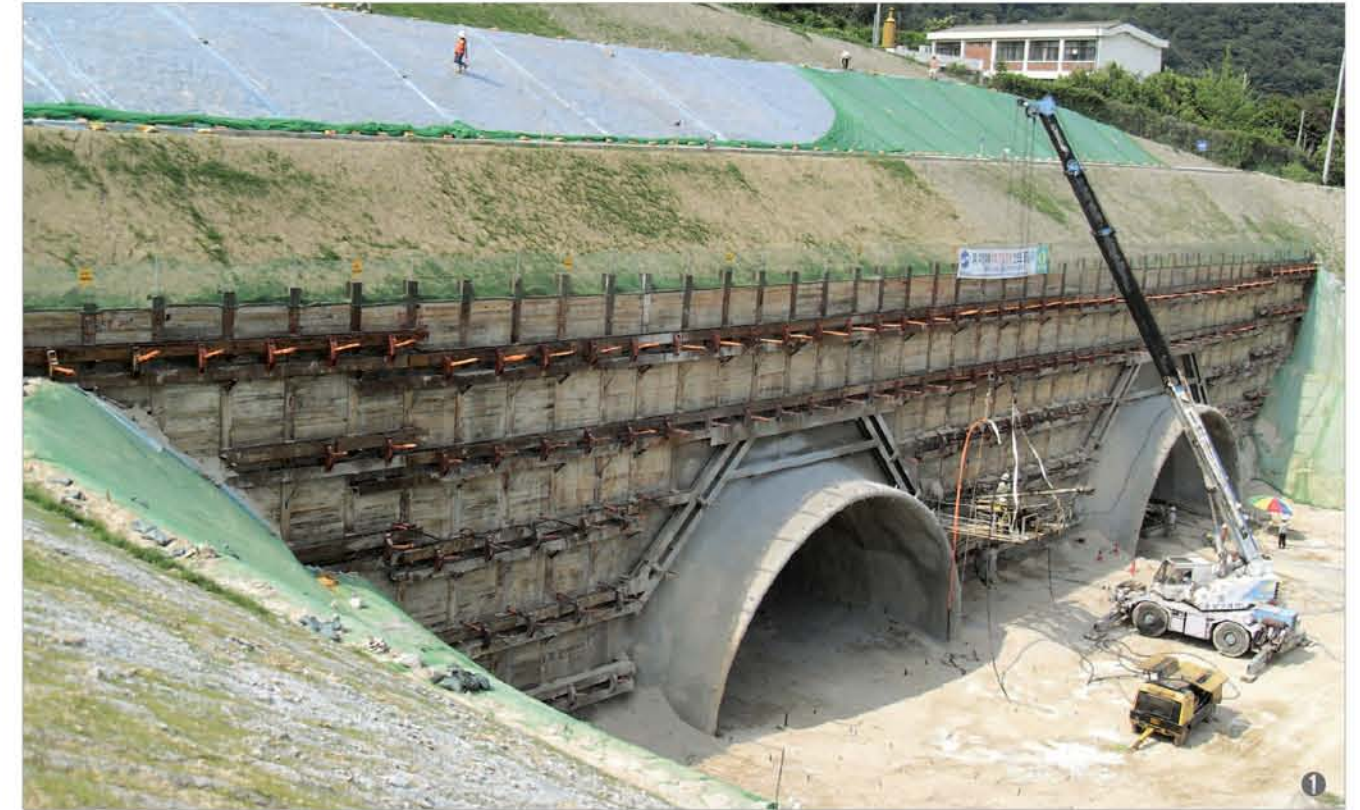
터널갱구부 가시설 상부 붕적층 지반에 압력식 쏘일네일링 보강
