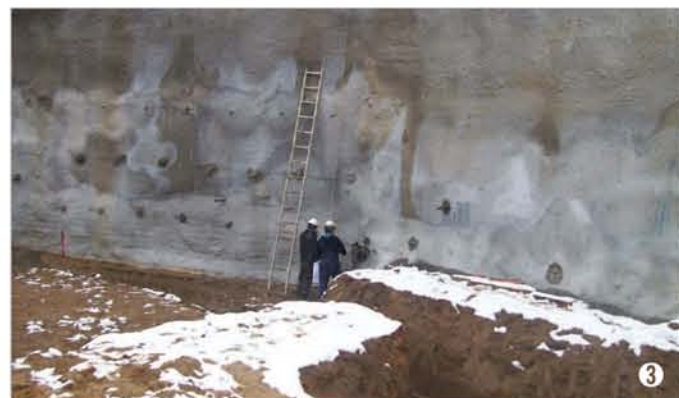
① 시공중 전경 ② 보강계획명면도 ③ 흙막이벽체 수직도 검사
