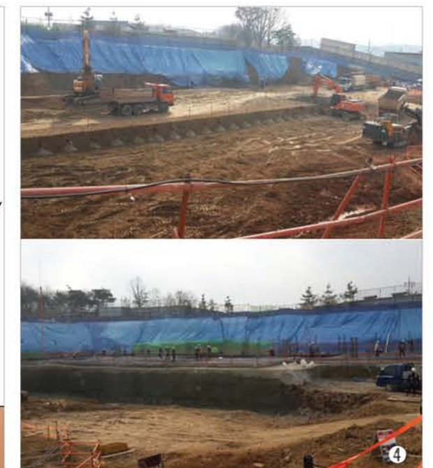
④ 시공중 전경-2
