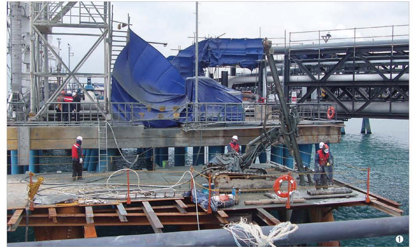
부두 하부 마이크로파일 공사
