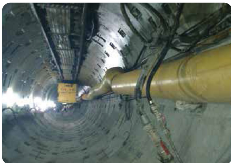
전력구 semi-shield backfill 그라우팅
