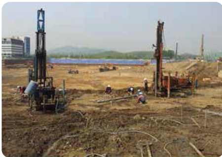
동남권 물류단지 지반보강 공사
