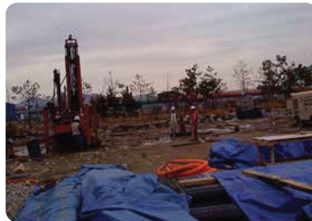
부산 강서구 한국 전력 수직구 차수공사
